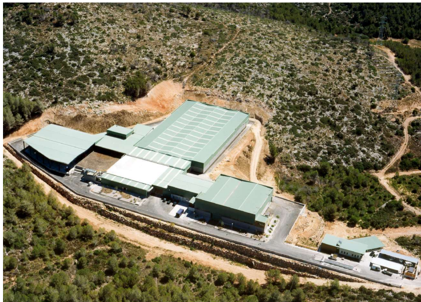
Planta de compostatge de Sant Pere de Ribes
